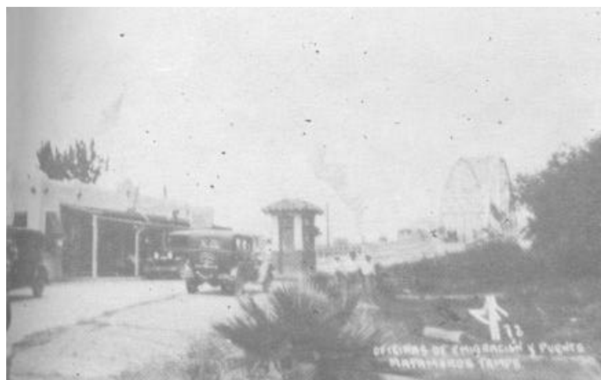
Otro aspecto del Puente en el que se ven las oficinas de Migración y Aduana de Matamoros.
