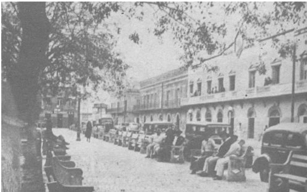
Otro aspecto de la Presidencia Municipal en el año de 1933. La foto está tomada desde la Plaza Hidalgo.
