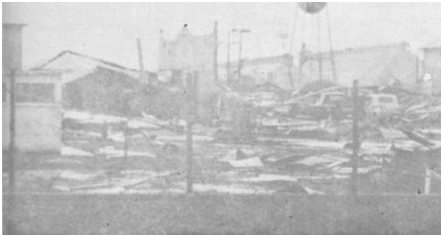
Bodegas totalmente destruidas.
