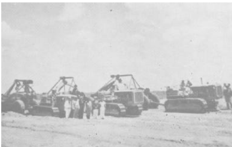
Aquí se ven las máquinas con que se construyó el tramo carretero entre Matamoros y San Fernando el año de 1941.
