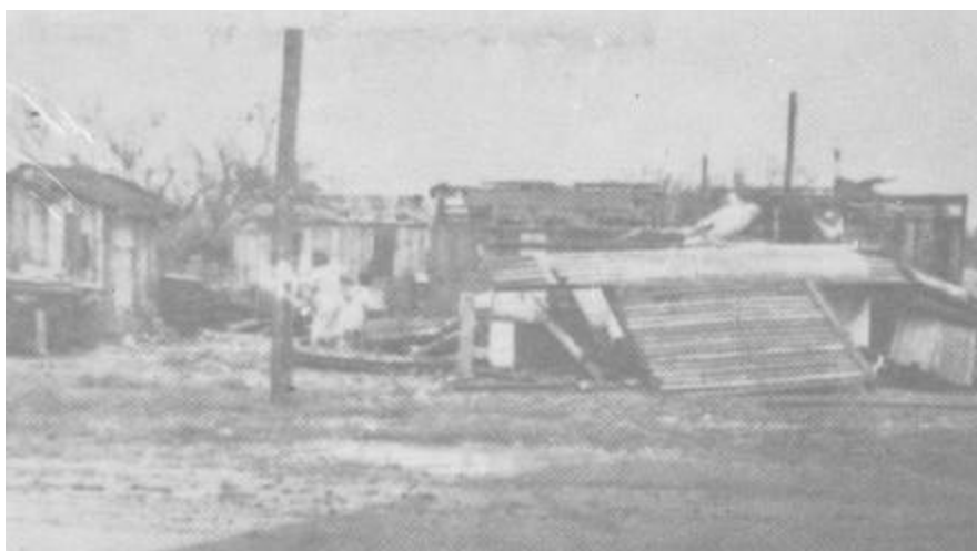
Casas derrumbadas en las colonias.
