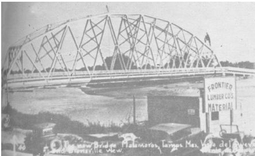
Puente Nuevo Internacional entre Matamoros y Brownsville. Obsérvese la caseta de materiales de la empresa constructora en la orilla del Río Bravo perteneciente a Matamoros.
