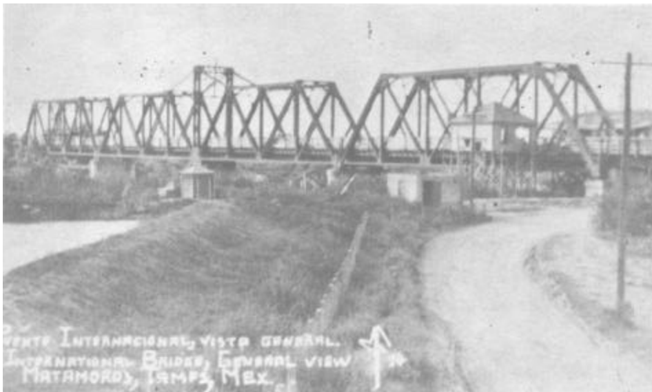
En esta fotografía se aprecia claramente el arco central entre la segunda y tercera sección donde se encontraba una caseta con la maquinaria especial que movía las dos secciones del puente.
