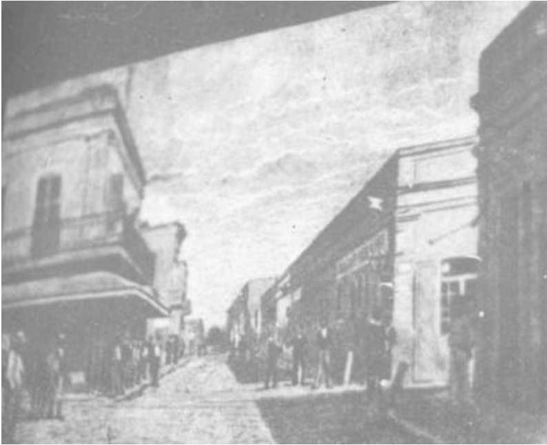
Esq. De Abasolo y 9. A la izq. Almacenes La India de D. Francisco Armendáriz; enfrente, Ferrería El Indio de D. Juan D. McMillan; y el edificio parcialmente visible a la der. lo ocupaba la negociación del Sr. Félix LaViolette. Año de 1870.
