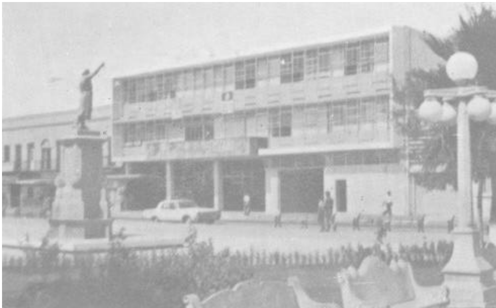
Fachada del Palacio Municipal, tomada desde un ángulo de la Plaza Hidalgo.
