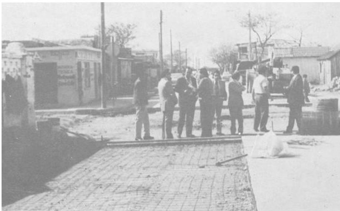
La mitad de la calle ya tiene concreto.
