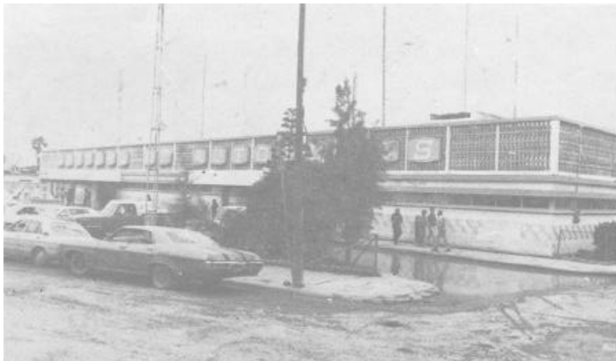
Fachada de la Central de Autobuses “LUCIO BLANCO”
