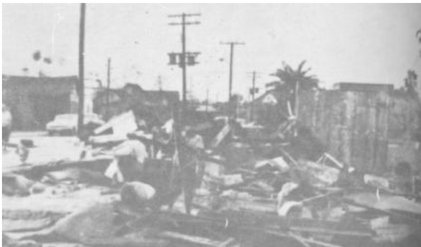
Escombros de lo que fueron hogares.
