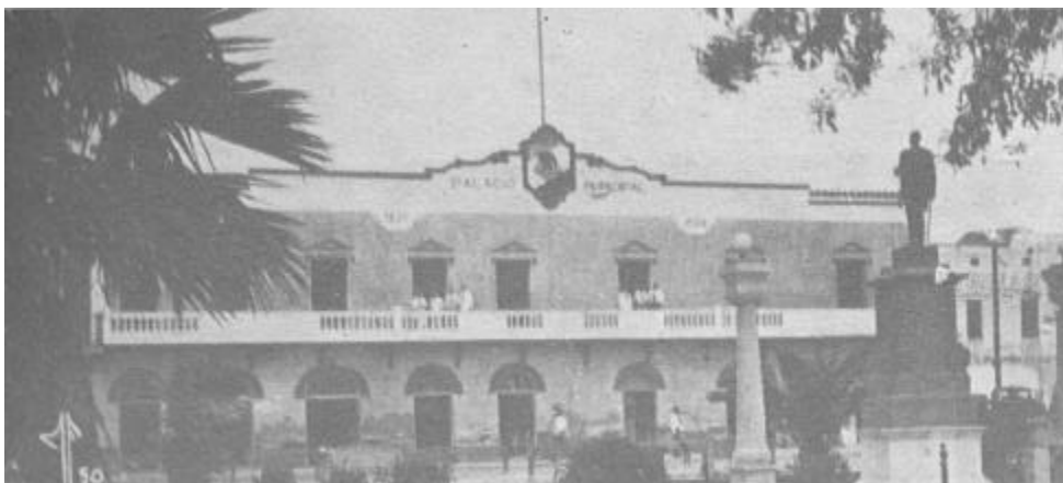
En 1934 fue captada esta fotografía del Palacio Municipal que había sido reparado y pintado después del ciclón de 1933.
