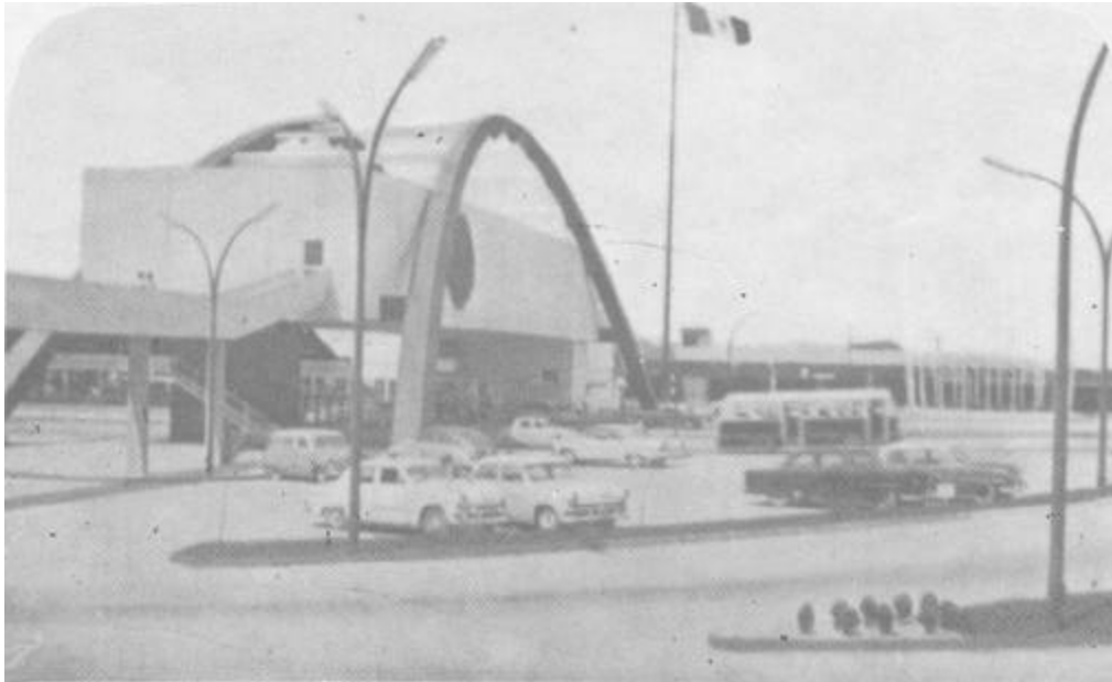
Vista lateral de la puerta México.
