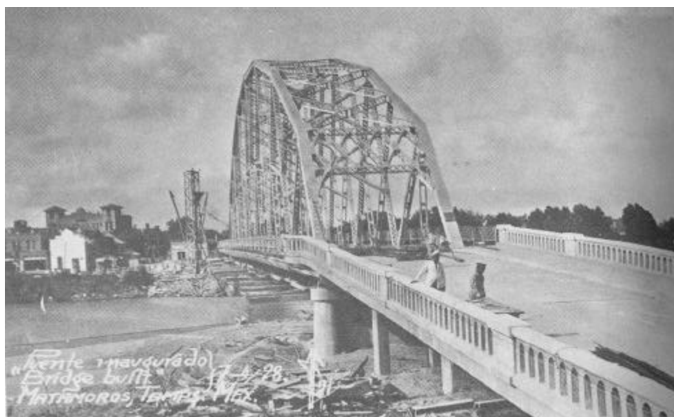
Otro aspecto del puente nuevo. Obsérvese al fondo (del lado de Brownsville) una pluma colocando tramos de fierro en el puente.
