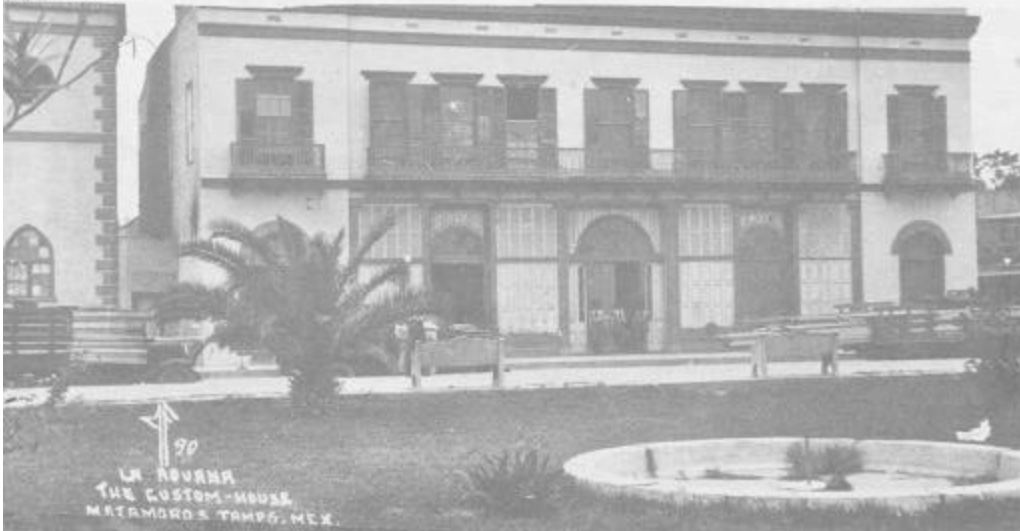
Edificio de la Aduana visto desde la Plaza Hidalgo en 1942.
