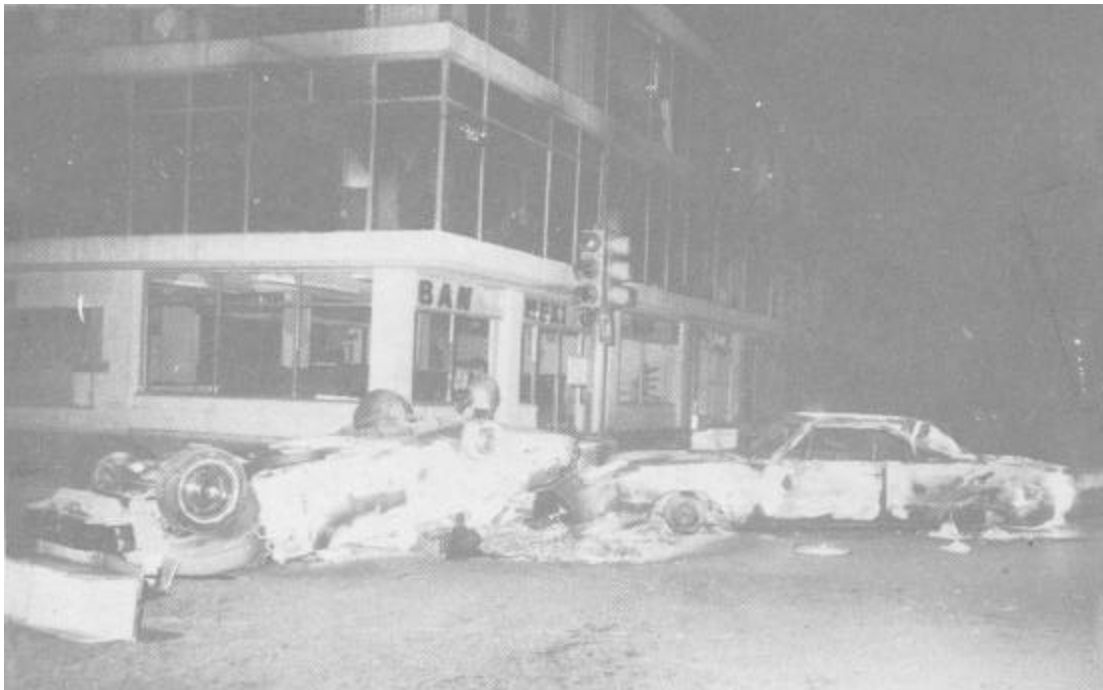
El edificio Magdalena resulto seriamente dañado. Véase el Banco Mexicano del Norte (Hoy Banca Somex) saqueado y en la calle dos autos más incendiados.
