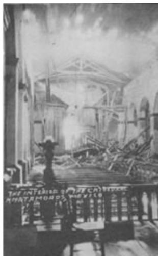
Foto del interior derrumbado (tomada desde el altar). Se puede apreciar la forma de construcción del techo de madera: Dos aguas de tejamanil en el exterior y cielo de machimbre en el interior.
