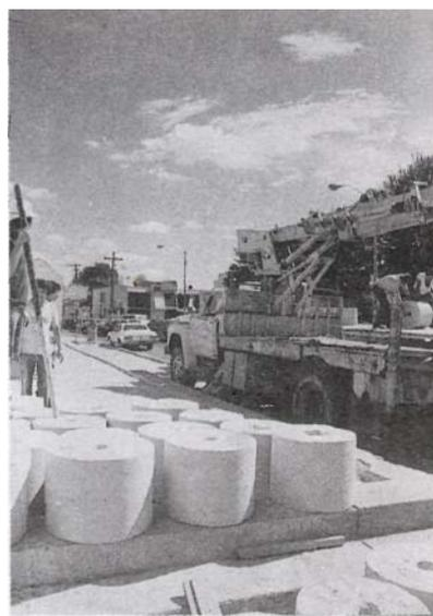
Trabajo intenso: Colocación de cantera en ambas torres, recubrimiento con vitroloseta en las dos torres; camión grúa descargando los bloques cilindricos de cantera para construir las columnas, instalación de las losas de cantera
