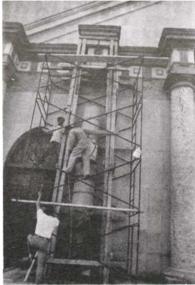
Instalación de la primera columna de cantera sólida
