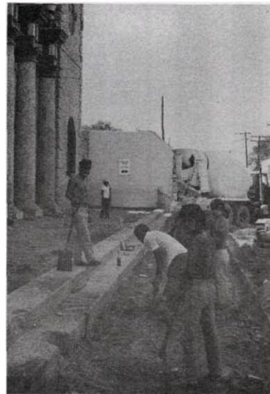
Albañiles preparándose para vaciar el firme de concreto de la banqueta exterior
