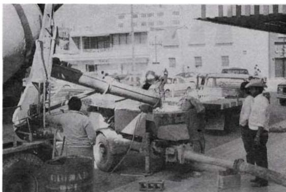
Moderno equipo para bombear el concreto y colar la placa
